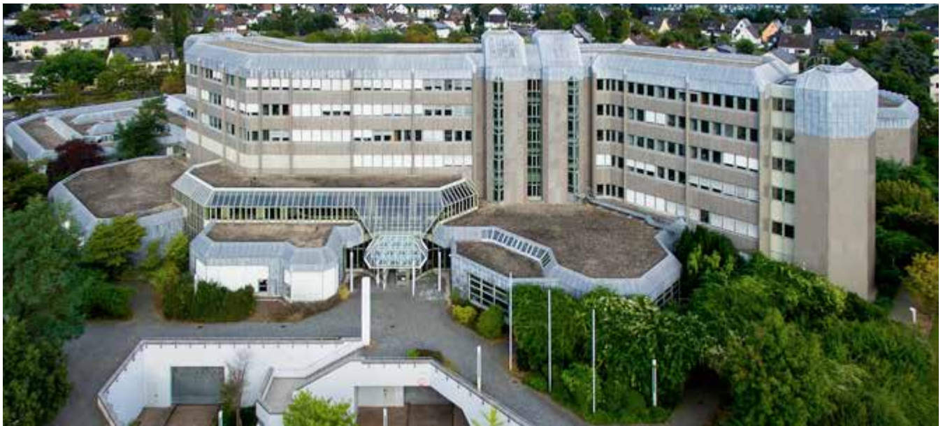
Eingangsbereich der Dienststelle des Bundesarchivs in Koblenz (BArch B 198 Bild-2016-0922-001/Günter Weber)
